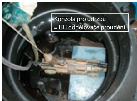
Kontrola úspěšného propláchnutí kamerou s otočnou hlavou, kamerou na konzole pro údržbu v počáteční šachtě v zařízení SediPipe L
