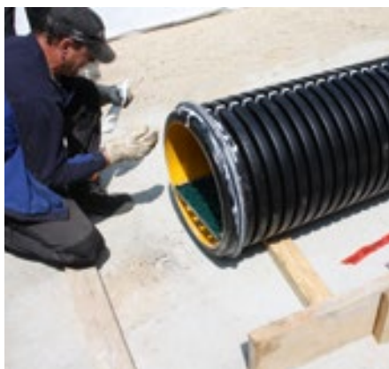
Těsnění s kluzným prostředkem
