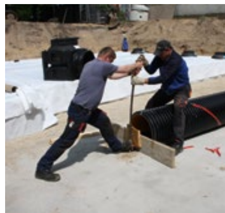
Montáž sedimentační trubky
