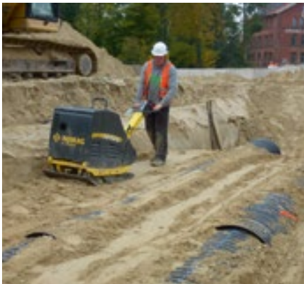
Zhutnění bočního obsypu
